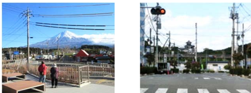
写真 2-3 景観を損なう電柱・電線の事例（出典：国土交通省 HP）
