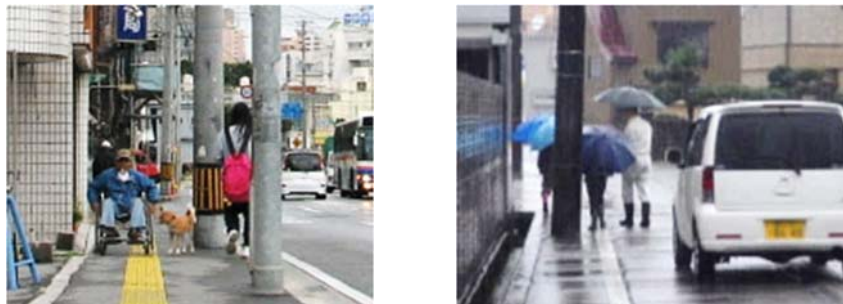
写真 2-2 歩行空間の支障となる電柱の事例（出典：国土交通省 HP）
