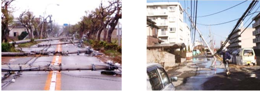
写真 2-1 災害時の電柱倒壊の事例（出典：国土交通省 HP）
