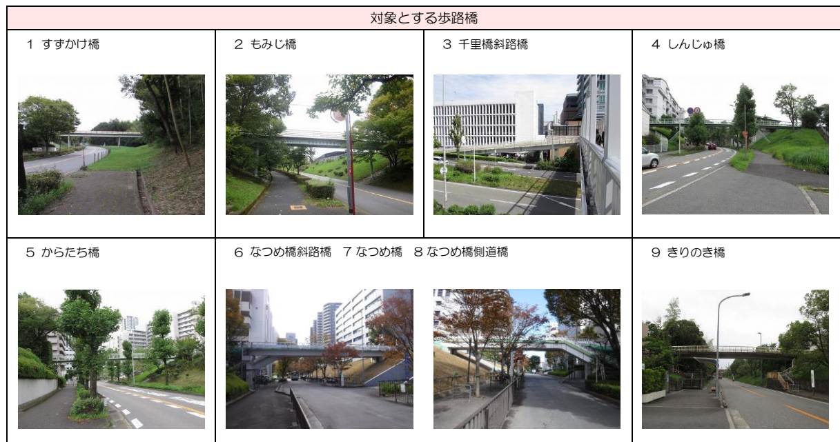
図 3-1 長寿命化修繕計画の対象とする歩路橋の状況
