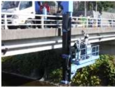
写真 1.1 橋梁点検車による点検状況
